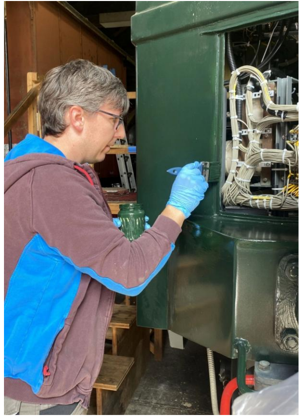
Bild 3 David bessert einige Farbschäden aus
