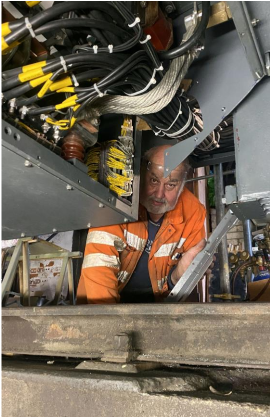
Bild 2 Franz stellt die Verschaltungen am Hüpf-Kasten fertig
